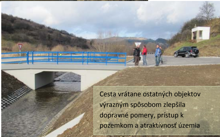
Pri výstavbe poľnej cesty medzi Vyšnými a Nižnými Ružbachmi bolo potrebné vybudovať mostný objekt.
