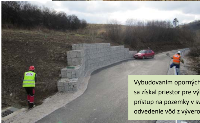
Cesta vrátane ostatných objektov výrazným spôsobom zlepšila dopravné pomery, prístup k pozemkom a atraktivnosť územia
